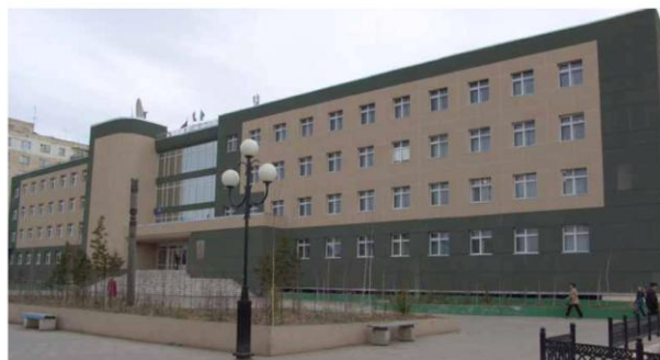
Политехнический институт, г. Мирный
