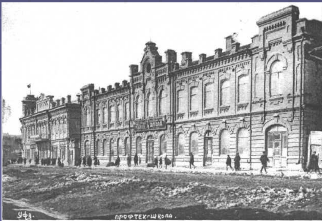
Здание бывшей Уфимской профтехшколы по ул. Центральной, 7, в котором размещалось V (химическое) отделение УФИ. Фото 20-х годов.
