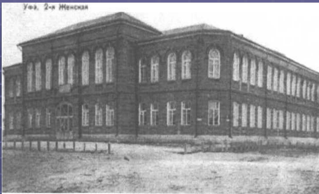
Здание бывшей Уфимской 2-й женской гимназии по ул. Большой Успенской, 19, в котором размещалось Центральное отделение УФИ. Фото 20-х годов
