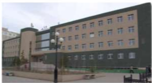
Политехнический институт, г. Мирный
